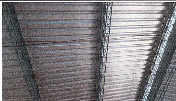
Foto 5: Mejoramiento de las vigas de hierro.
