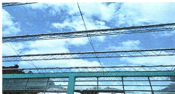
Foto 5: Mejoramiento de las vigas de hierro.
