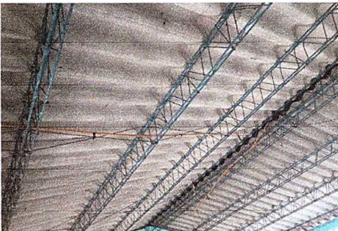
Foto 5: Mejoramiento de las vigas de hierro
