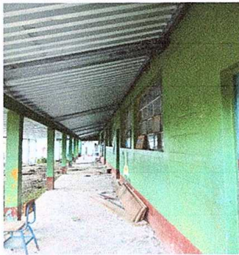
Foto 3: Sustrucción de estructura de soporte de madera, por metal
