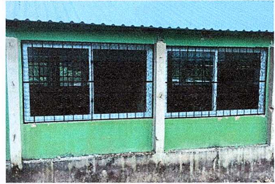
Foto 4: Sustrucción de ventanas de metal por metal mas vidrio
