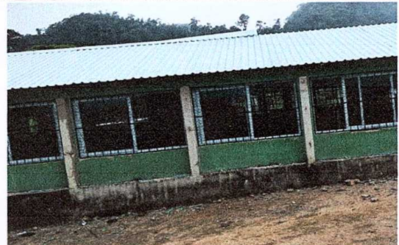
Foto 6: Sustrucción de balcones de metal
