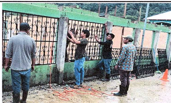
Foto 6: Sustitución de balcones de metal
