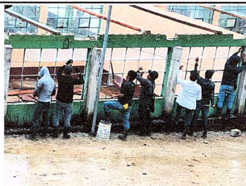
Foto 4: Sustitución de ventanas de metal por metal mas vidrio
