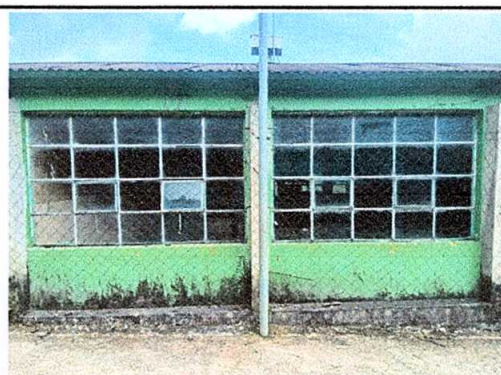
Foto 4: Sustrucción de ventanas de metal por metal mas vidrio
