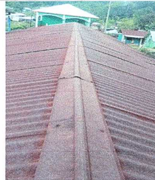
Foto 2: Sustrucción de capote de lámina para lámina troquelada
