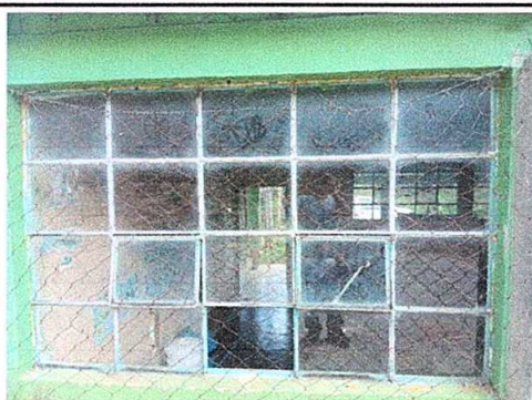
Foto 5: Sustrucción de ventanas de metal por metal mas vidrio
