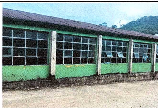
Foto 6: Sustrucción de balcones de metal
