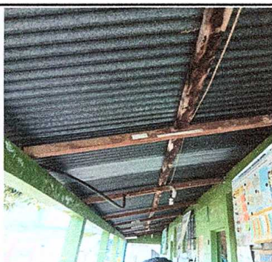
Foto 3: Sustrucción de estructura de soporte de madera, por metal
