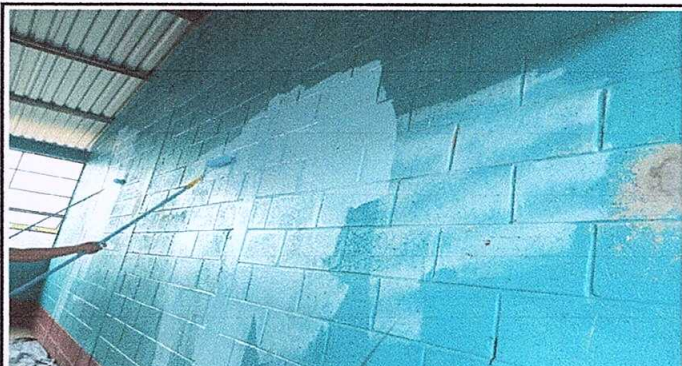
Foto 4: pintura en mal estado
