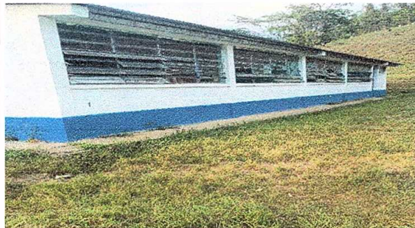
Cambio de techo
