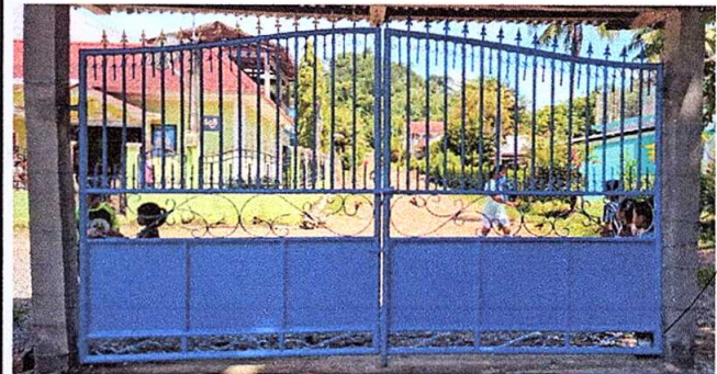
Foto 6: sustitución de porton de metal.
