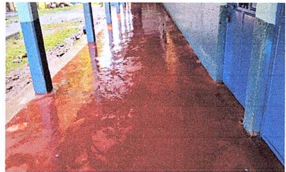
Foto 4: sustitución de piso de cemento líquido.
