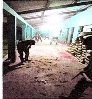
Foto 4: sustitución de piso de cemento líquido.
