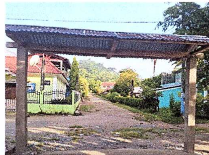
Foto 6: sustitución de porton de metal.
