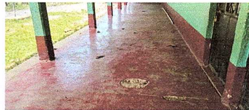
Foto 4: sustitución de piso de cemento líquido.
