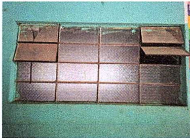
Foto 3: sustitución de balcones de metal en ventanas.
