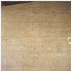
Foto 5: Pintura en muros interiores y exteriores.
