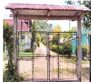
Foto 6: sustitución de porton de metal.
