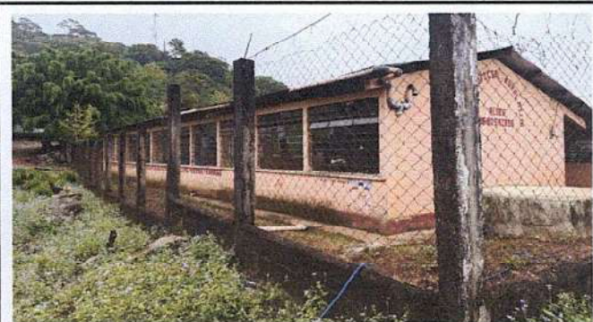
Foto 3: Reparacion de malla galvanizada
