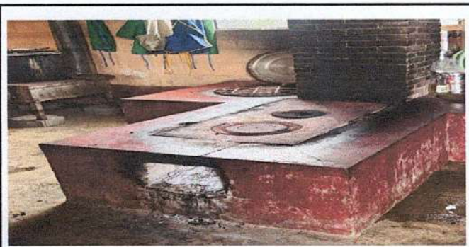
Foto 5: sustitucion de plancha de metal
