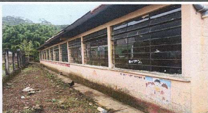
Foto1: pintura de muros interiores y exteriores
