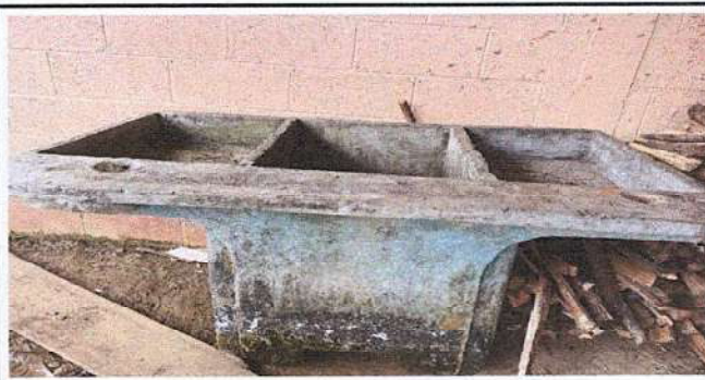
Foto 6: Sustitucion de pila de dos lavaderos
