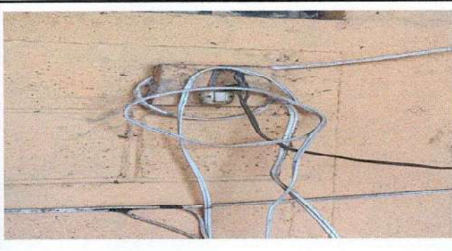
Foto 4: sustitucion de cableado electrico
