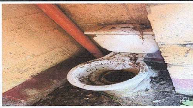
Foto 2: Sustitucion de inodoros
