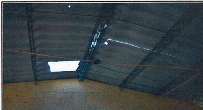
Foto1: Cubierta de lamina (cocina)
