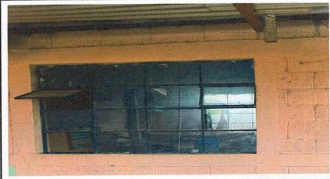
Foto 4: sustitucion de ventana a PVC 1.60 altura por 1.80 de ancho
