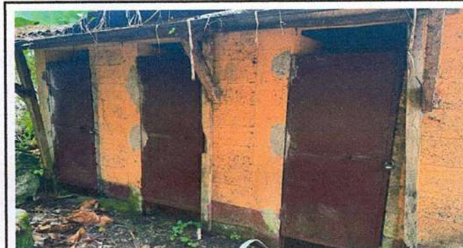
Foto 3: Sustitucion de puertas de metal
