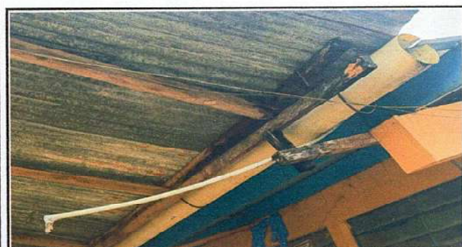
Foto 5: Sustitucion de canal PVC
