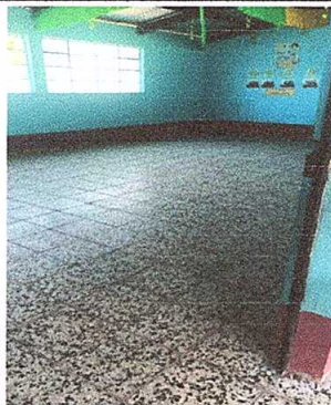
Foto 1: Sustitución de piso de granito
