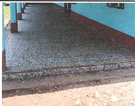
Foto 6: Sustitución de piso de torta de concreto
