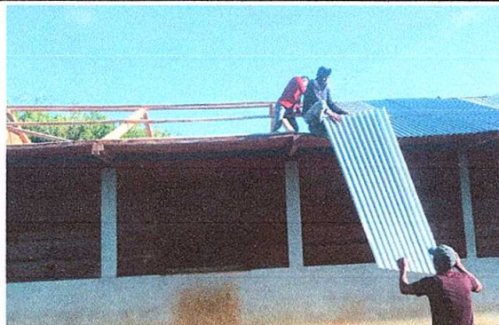
Foto 2: Sustrucción de lámina, por lámina troquelada aluzinc calibre 26
