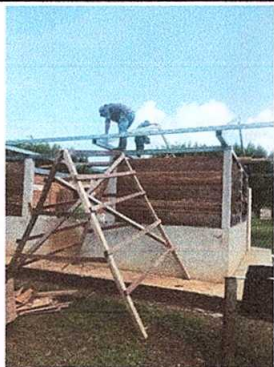
Foto 3: Sustrucción de estructura de soporte de madera, por metal
