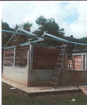
Foto 3: Sustrucción de estructura de soporte de madera, por metal
