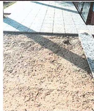
Foto 6: Sustrucción de piso de torta de concreto
