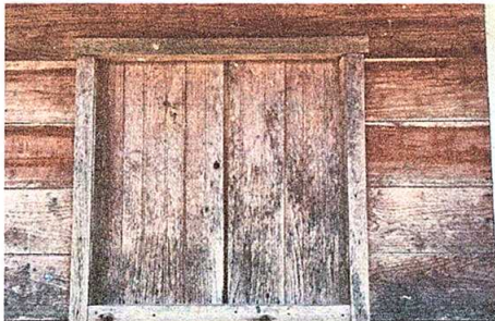
Foto 5: Sustitución de ventanas de madera por metal mas vidrio (2.34*1.70)
