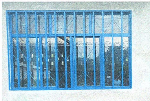
FOTO 6: Sustitución de balcones de metal (1.5m*2.40m)(1 balcon)
