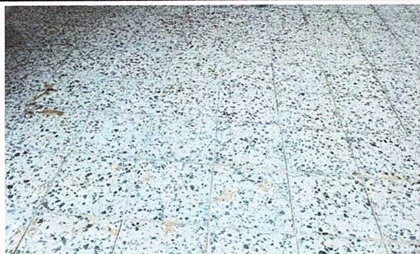
FOTO 3: Sustitución de piso de granito
