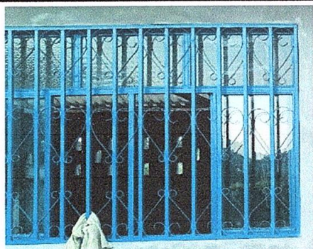
FOTO 5: Sustitución de estructura de metal de ventana (1.5m*2.40m)(1 ventana)
