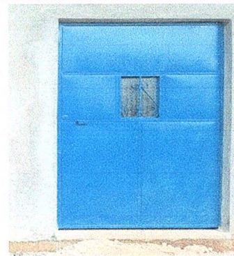
FOTO 4: Sustitución de puerta (1.20m * 2.10m)
