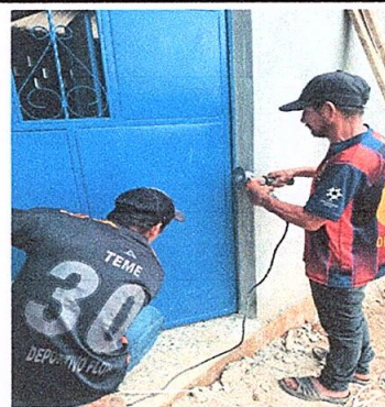
FOTO 4: Sustitución de puerta (1.20m * 2.10m)
