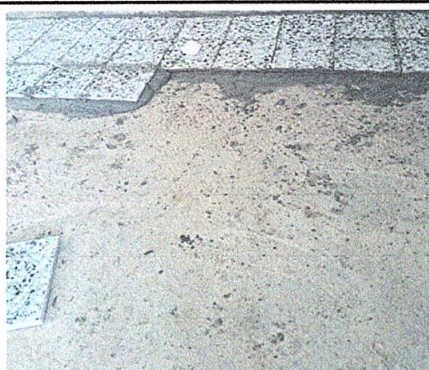
FOTO 3: Sustitución de piso de granito
