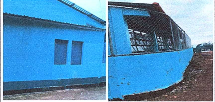
Foto 8: Pintura en muros exteriores e interiores
