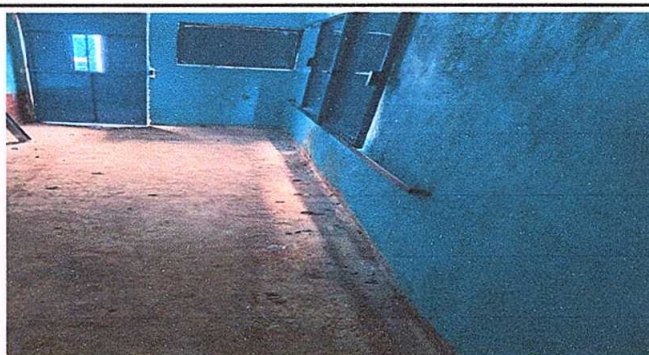
Foto 6: Sustitución de piso de torta de concreto
