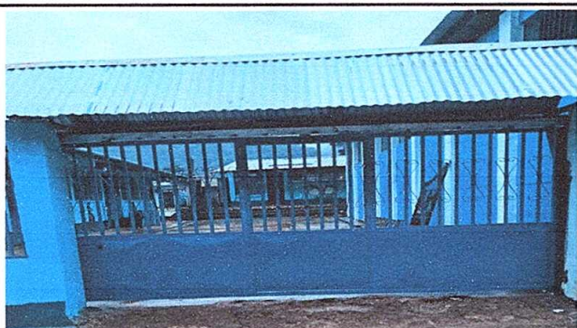
Foto 3: Sustitución de portón de metal (2 metros de alto * 2.90 metros de ancho)
