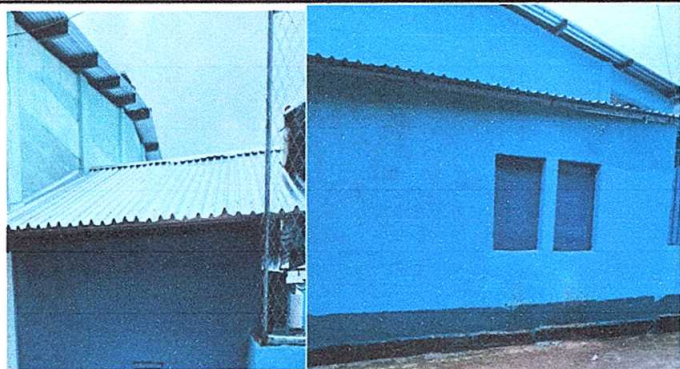
Foto1: Sustitución de lámina, por lámina troquelada aluzinc
