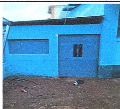
Foto 4: Sustitución de puerta (2 metros de alto * 0.80 metros de ancho)
