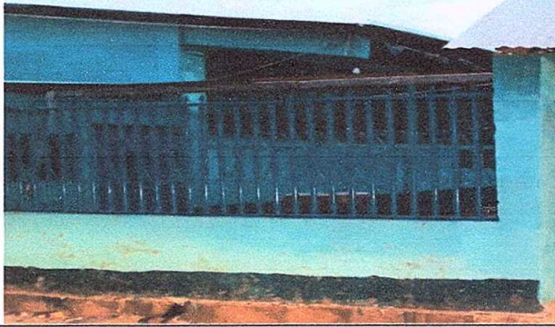
Foto 7: Reparación con tubo hg y malla galvanizada
