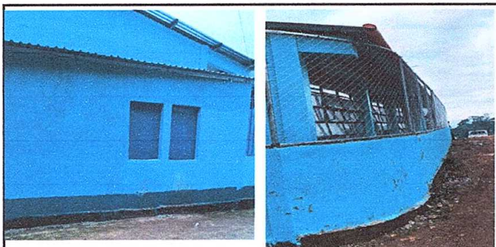
Foto 5: Repello en muro y paredes
