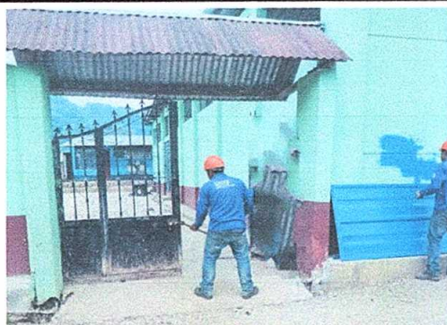
Foto 3: Sustitución de portón de metal (2 metros de alto * 2.90 metros de ancho)
