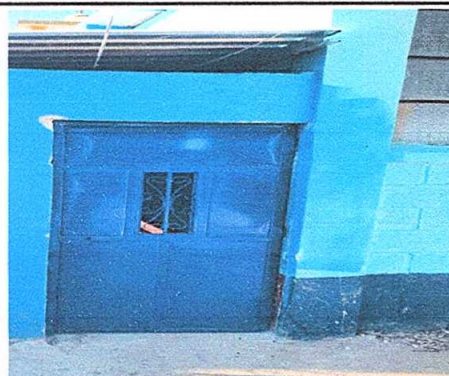
Foto 4: Sustitución de puerta (2 metros de alto * 0.80 metros de ancho)
