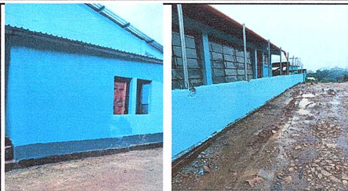
Foto 8: Pintura en muros exteriores e interiores
