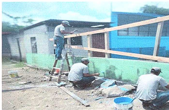
Foto 7: Reparación con tubo hg y malla galvanizada
