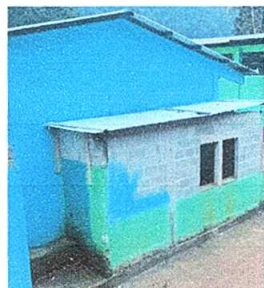
Foto 5: Repello en muro y paredes
