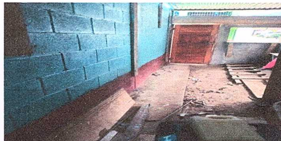
Foto 6: Sustitución de piso de torta de concreto
