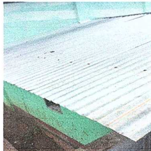
Foto1: Sustitución de lámina, por lámina troquelada aluzinc
