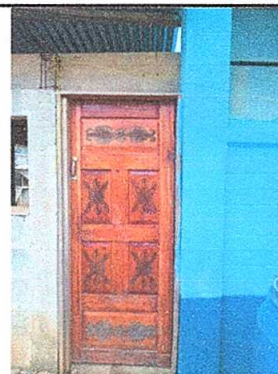
Foto 4: Sustitución de puerta (2 metros de alto * 0.80 metros de ancho)
