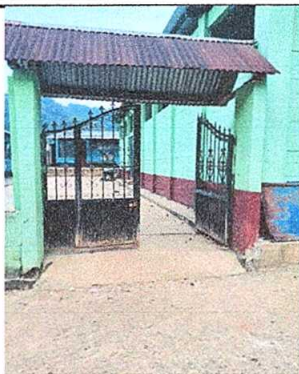
Foto 3: Sustitución de portón de metal (2 metros de alto * 2.90 metros de ancho)
