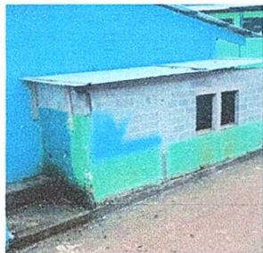
Foto1: Sustitución de lámina, por lámina troquelada aluzinc
