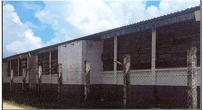
Foto 4: Necesidad de colocación de costaneras
