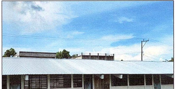
Foto 6: Laminas de corredor en malas condiciones.
