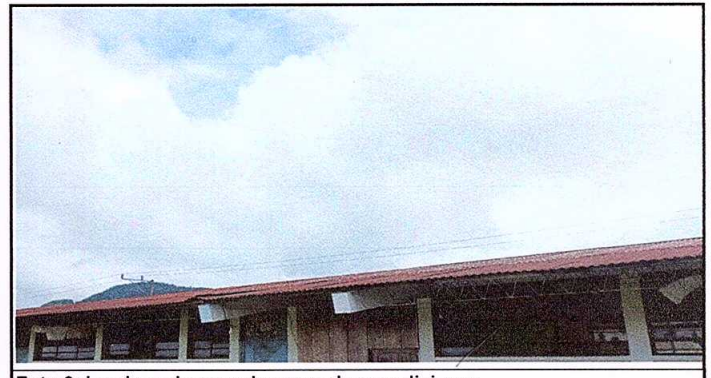
Foto 6: Laminas de corredor en malas condiciones
