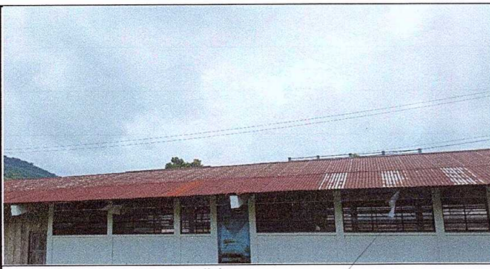
Foto 5: Capotes en malas condiciones
