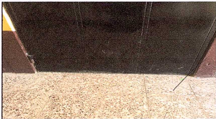
Foto1: Mantenimiento a puerta de metal, 3 puertas
