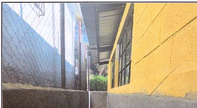
Foto 3: Mejoramiento con canal de metal
