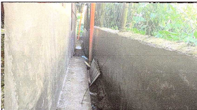
Foto 6: Repello en muro
