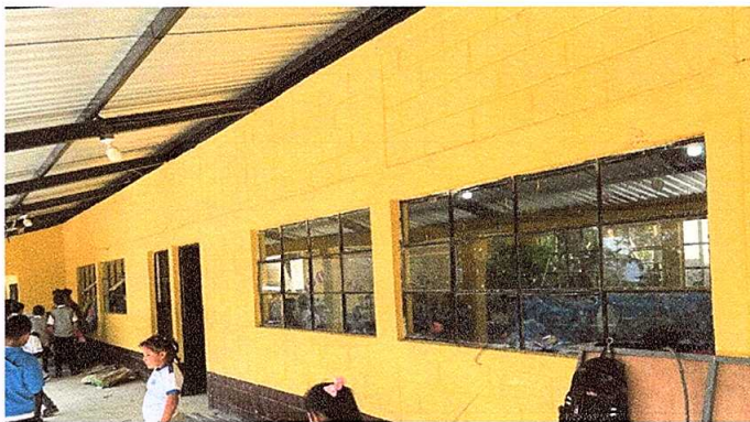
Foto 4: Pintura en muros exteriores
