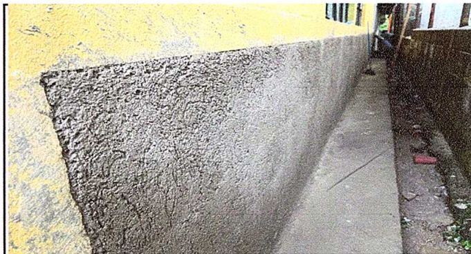
Foto 6: Repello en muro
