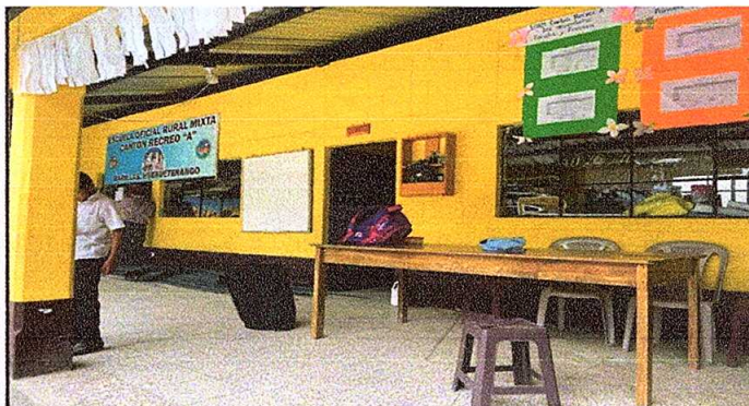
Foto 4: Pintura en muros exteriores
