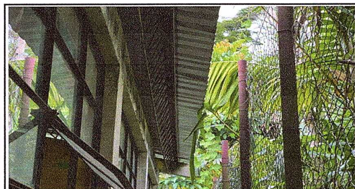
Foto 3: Mejoramiento con canal de metal
