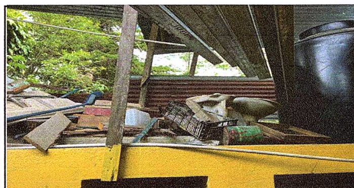
Foto 5: Mejoramiento con depósito de agua 2.500 Litros
