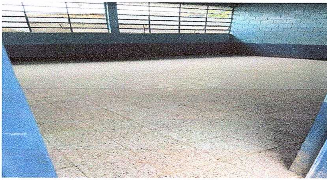
Foto1: Sustrucción de piso de concreto por piso granito
