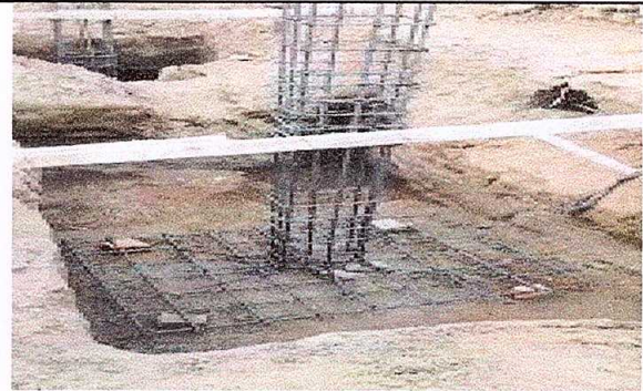
Foto 4: Sustitución de base de para deposito de agua
