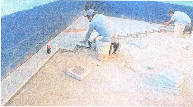
Foto1: Sustitución de piso de concreto por piso granito
