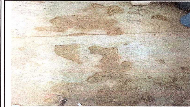
Foto1: Sustrucción de piso de concreto por piso granito
