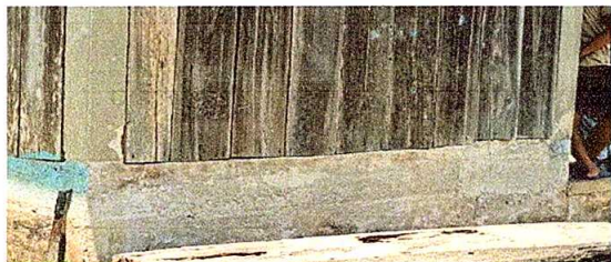
Foto 1: Mejoramiento de pared
