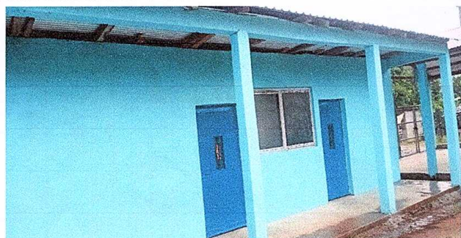
Foto 3: Sustitución de puertas de madera a metal
