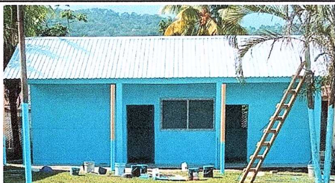
Foto 5: Pintura en muros interiores y exteriores
