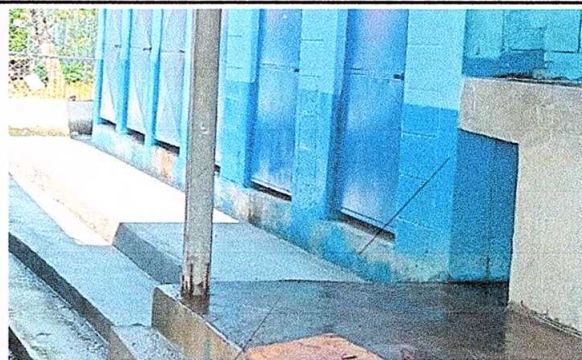
Foto 6: Torta de concreto
