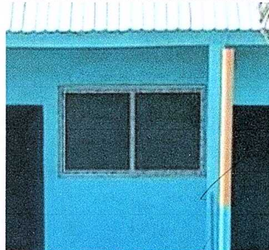
Foto 4: Sustitución de ventanas de madera a pvc
