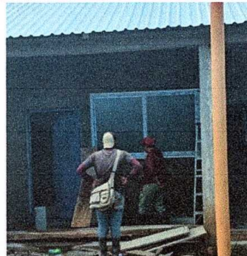
Foto 4: Sustitución de ventanas de madera a pvc
