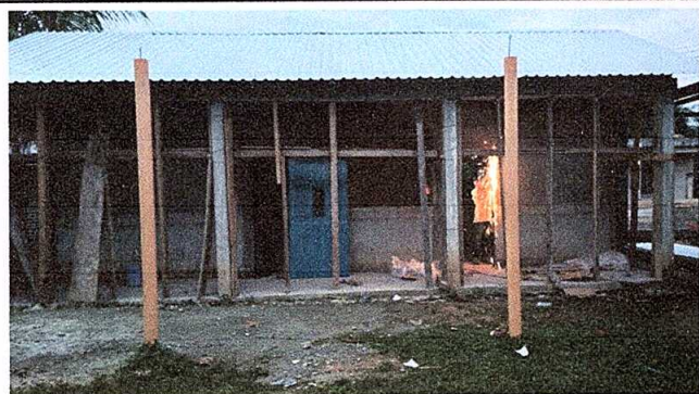
Foto 3: Sustitución de puertas de madera a metal
