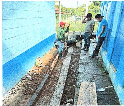
Foto 6: Torta de concreto
