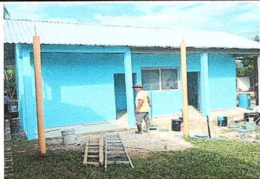
Foto 5: Pintura en muros interiores y exteriores
