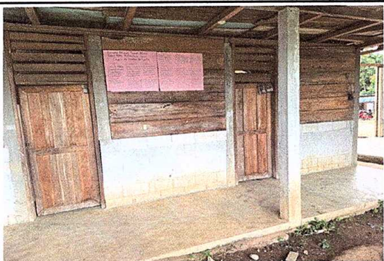
Foto 3: Sustitución de puertas de madera a metal
