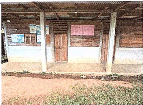
Foto 5: Pintura en muros interiores y exteriores
