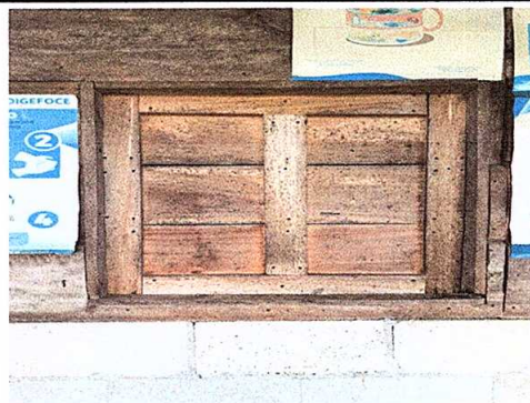
Foto 4: Sustitución de ventanas de madera a pvc
