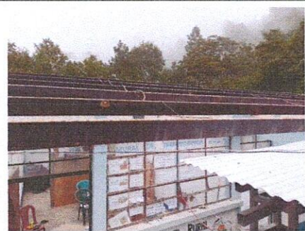
Foto 3: Desentechado para colocar láminas troqueladas.
