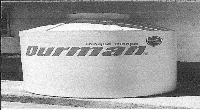
Foto 13: Sustitución de depósito de agua 1700lt.
