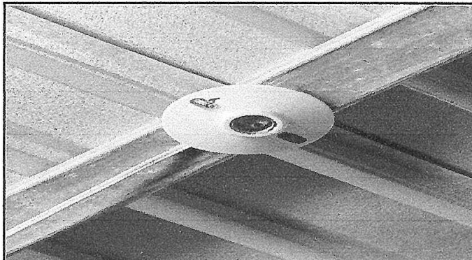
Foto 4: sustitución de plafoneras
