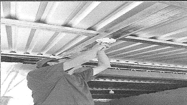
Foto 4: sustitución de plafoneras
