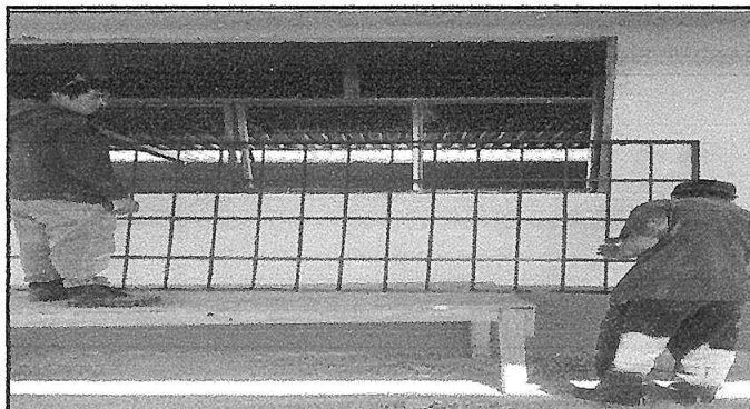
Foto 10: Sustitución de balcones de metal.
