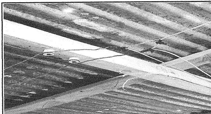
Foto 3: reparación de cableado eléctrico
