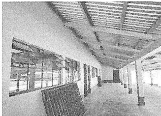
Foto 3: Preparando la estructuras de metal de ventanas con aplicación de pintura.
