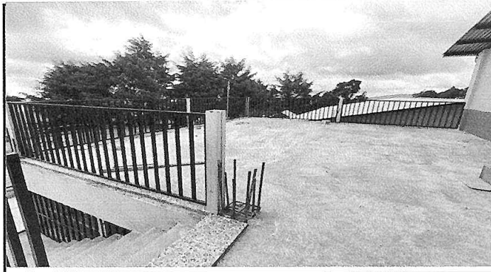
Foto 2: Mantenimiento a barandas de metal.
