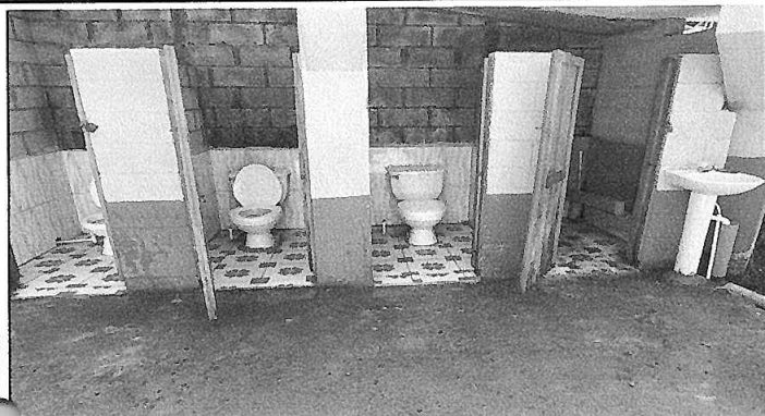
Foto 4.1: Sustitución de inodoro y sus accesorios
