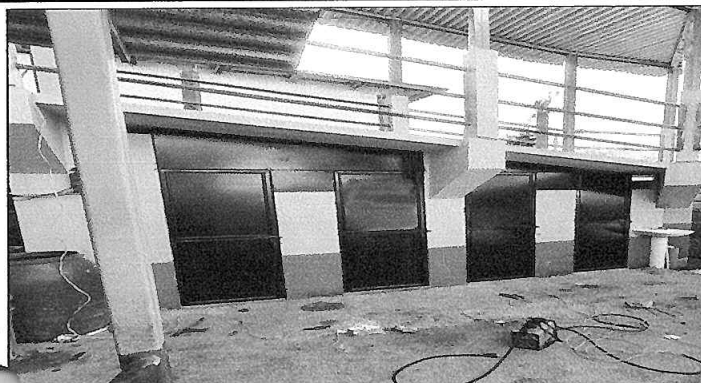
Foto1: Sustitución de puerta en servicios sanitarios
