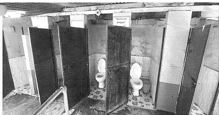
Foto 5: Sustitución de inodoro y sus accesorios
