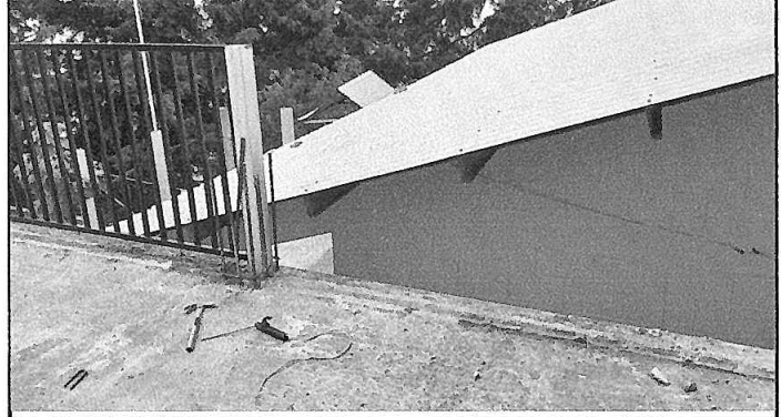
Foto 2: Mantenimiento a barandas de metal.
