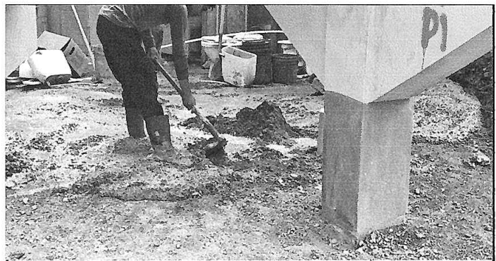
Foto 6: Reparación de plancha de concreto de patio (sanitario)
