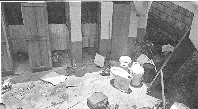
Foto 4.1: Sustitución de inodoro y sus accesorios
