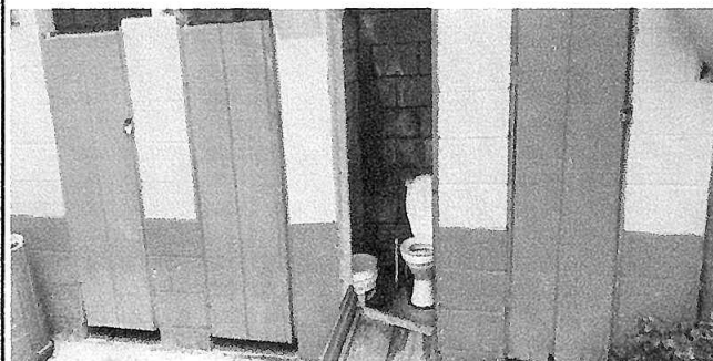
Foto 4.1: Sustitución de inodoro y sus accesorios
