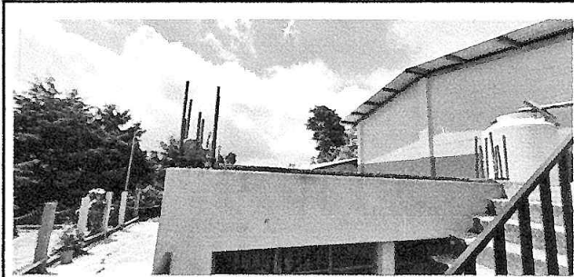
Foto 2: Mantenimiento a barandas de metal.
