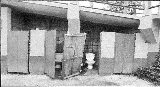
Foto 1: Sustrucción de puerta en servicios sanitarios
