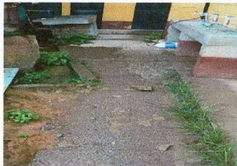
Foto 8: Sustitución de piso de torta de concreto
