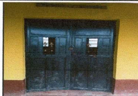
Foto 4: Sustitución de puerta
