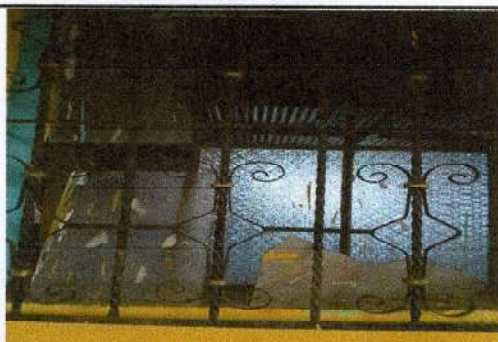
Foto 5: Sustitución de balcones
