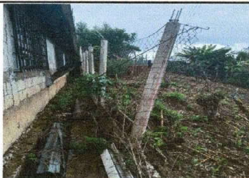
Foto 2: Sustitución de malla por malla galvanizada y tubo HG
