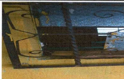
Foto 6: Sustitución de Vidrios
