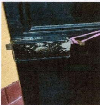
Foto 7: Sustitución de chapa
