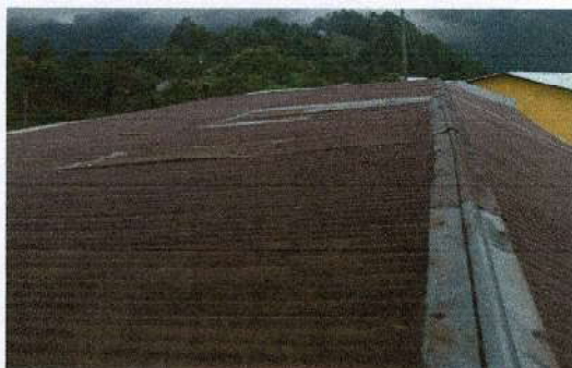
Foto 1: Sustitución de lámina por lámina troquelada
