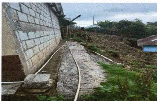
Foto 3: mejoramiento de muro de malla galvanizada y tubo HG.
