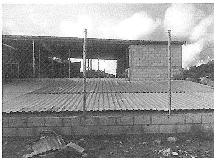
Foto. 13 Muro perimetral concluido
