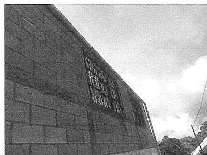
Foto 4: Ventanas ya colocadas en cocina
