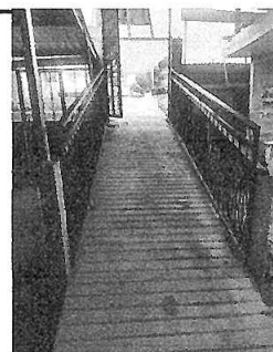
Foto 12: Barandas ya colocadas
