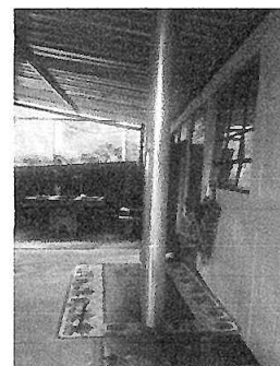
Foto 10: Plancha con su chimenea
