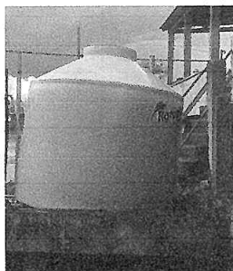
Foto 9: Deposito de agua ya ubicado en su lugar
