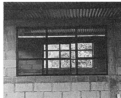
Foto 4: Instalando las ventanas
