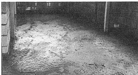
Foto 5: Haciendo limpieza para poder colocar el piso de granito.
