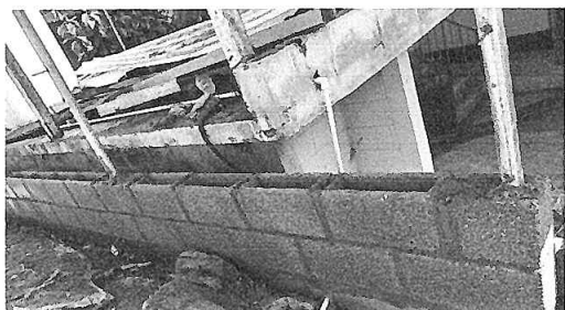
Foto. 13 Colocación de block y tubos para el muro perimetral.
