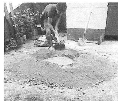
Foto 6: Preparación del concreto para la cuneta .
