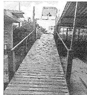
Foto 6: Sustitución de barandas
