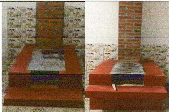
Foto 7: Sustitución de plancha de metal de 3 hornillas
