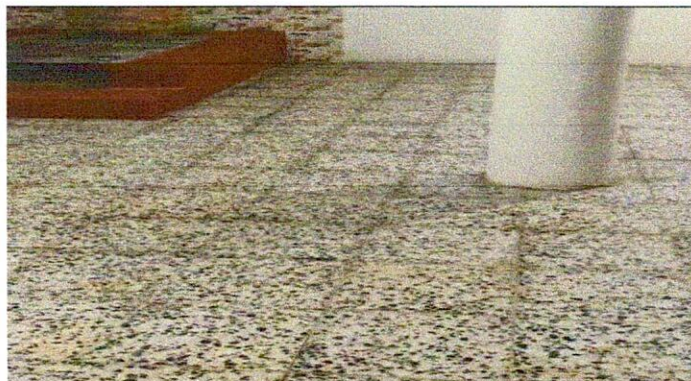
Foto 4: Sustitución de piso de granito
