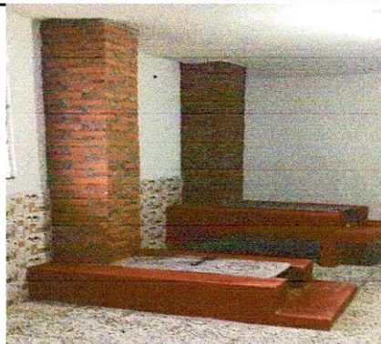
Foto 8: Sustitución de chimenea de ladrillo
