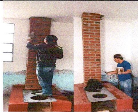
Foto 8: Sustitución de chimenea de ladrillo
