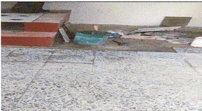
Foto 4: Sustitución de piso de granito
