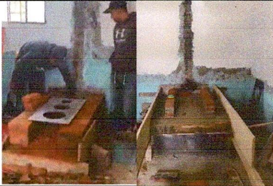
Foto 7: Sustitución de plancha de metal de 3 hornillas
