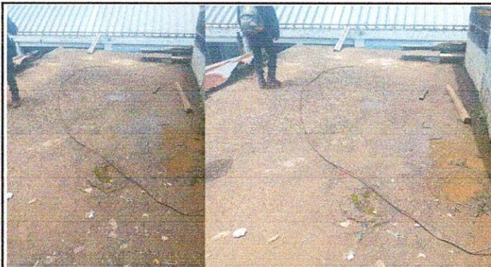
Foto 1: Impermeabilización de losa
