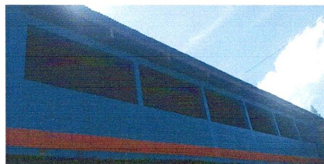
Foto 10: Mejoramiento de balcones de metal
