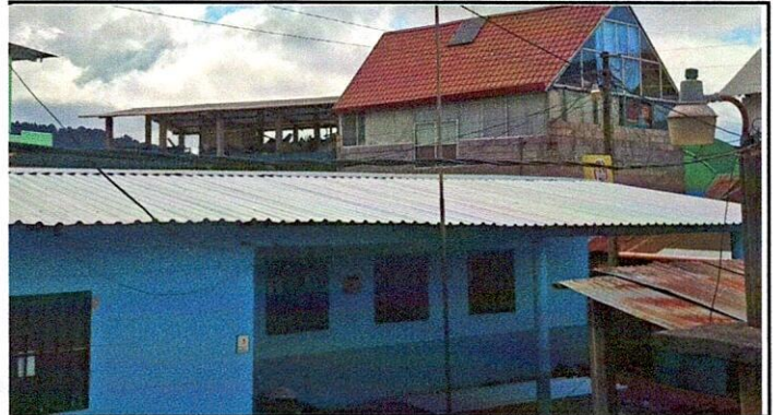
Foto 1.1: CUBIERTA DE LAMINA
