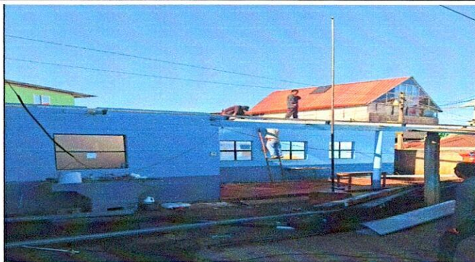
Foto 1.1: CUBIERTA DE LAMINA
