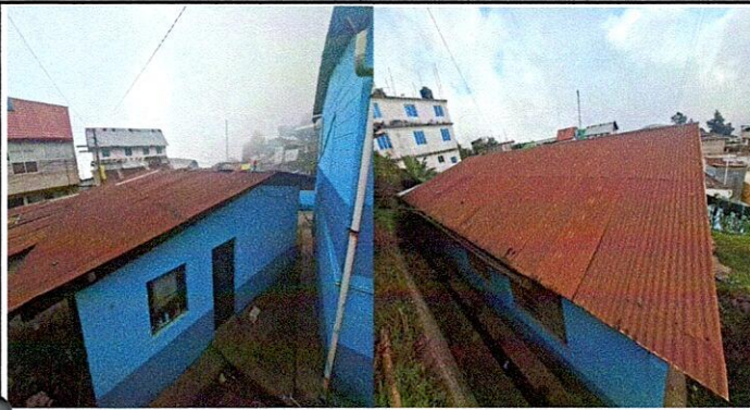
Foto1: CUBIERTA DE LAMINA
