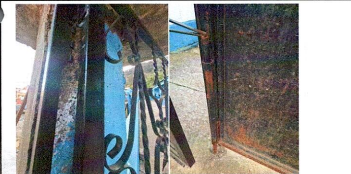
Foto 3.1: PORTON DE METAL
